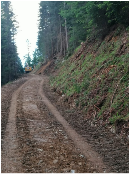
Viehtriebweg im Bau
