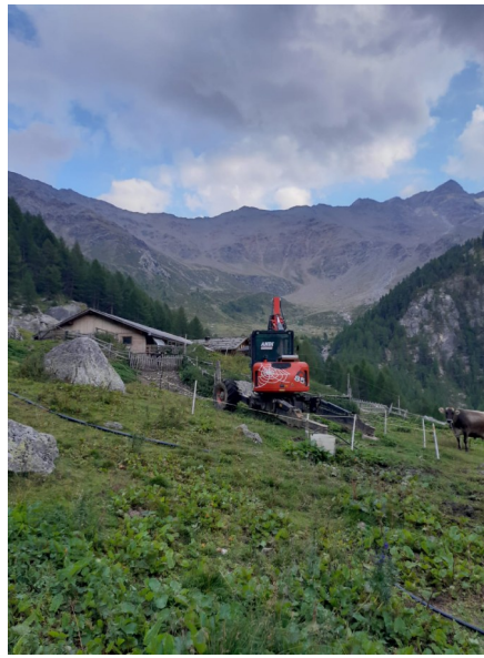
Bagger auf der Soyalm
